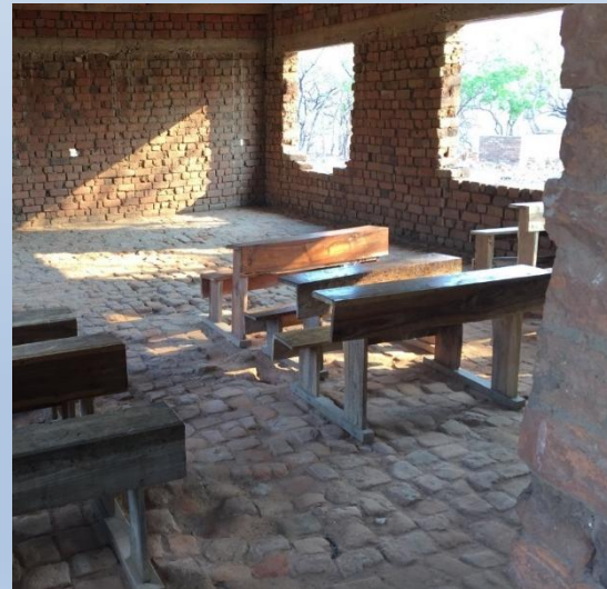
Dieses Klassenzimmer wird mit unseren gespendeten Zementsäcken ausgebaut
